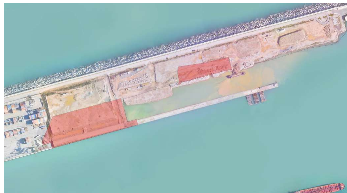
Figura 28: Imagen aérea de los nuevos rellenos (en rojo) en el muelle Adosado
